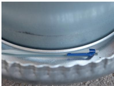
**Conseil :** placer un stylo dans l'interstice pour vérifier si l'écart est suffisant. Si, bien que la goupille ait été placée dans le trou inférieur, l'interstice reste supérieur à 1,5 cm, un trou supplémentaire peut si nécessaire être percé.
