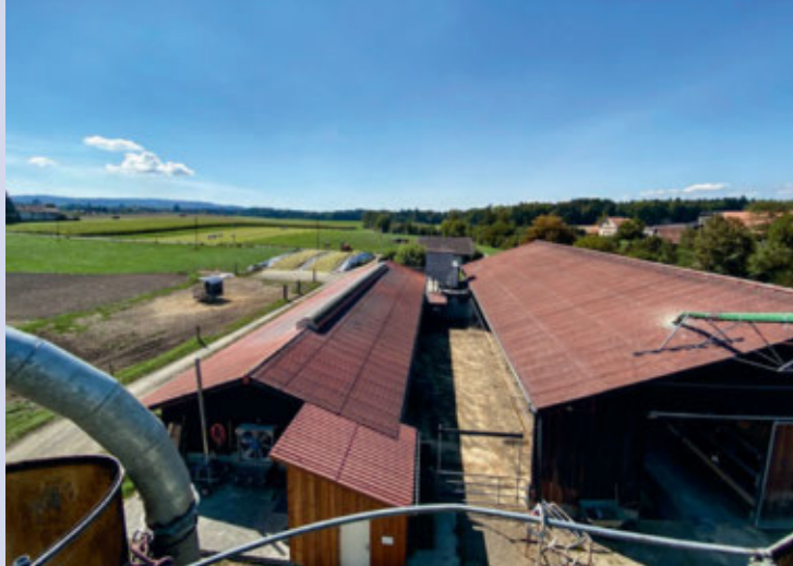
Im Milchviehstall links sind die Liegeboxen, dazwischen ist der Laufhof und im Gebäude rechts der Fressbereich. In diesem Gebäude befinden sich auch die Kälber und die Galtkühe. Bild: zvg
